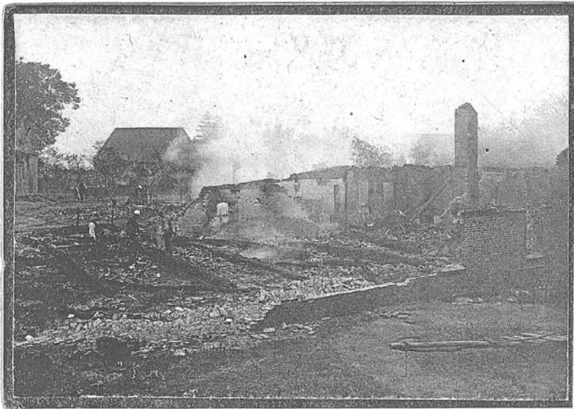
Die Brandruine des Hofes von Walter Siems. (ehemals Fam. Wulf). Der Hof wurde an dieser Stelle (heute an der Aue) nicht wieder aufgebaut.
