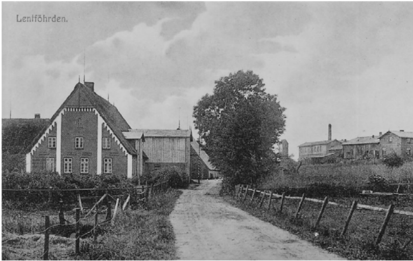
Gebäude vor dem Brand (Ansicht von Kieler Straße)
